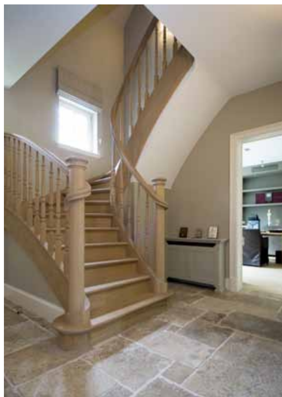
De Bourgondische dallen in de traphal zijn in wildverband gelegd. De trap zelf bestaat uit eikenhout dat grijs geolied is in dezelfde kleur als de vloer van de eerste verdieping.
