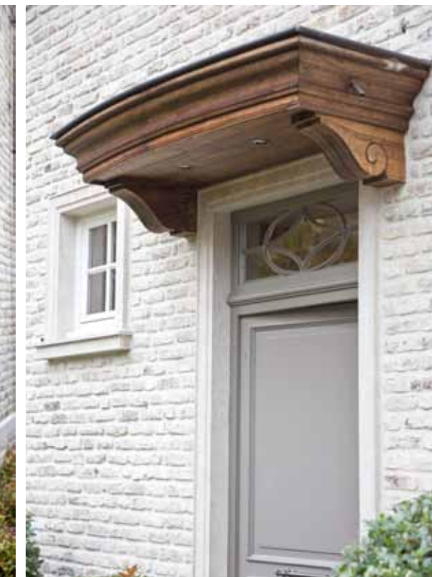
Boven de voordeur hangt een luifel, die voor een droge instap zorgt. De luifel is vervaardigd van padoek, een Afrikaanse hardhoutsoort. Het overige buitenschrijnwerk is van meranti, een Aziatische hardhoutsoort. De omlijsting rond de voordeur bestaat uit de natuursteen massangis jaune claire.
