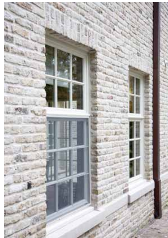
De Franse handvormstenen die voor de gevels gebruikt werden, zijn in wildverband gemetseld. “Op die manier ontstaat nog meer de sfeer van natuursteen, want natuursteen is zelf ook onregelmatig”, licht Stefan toe.
